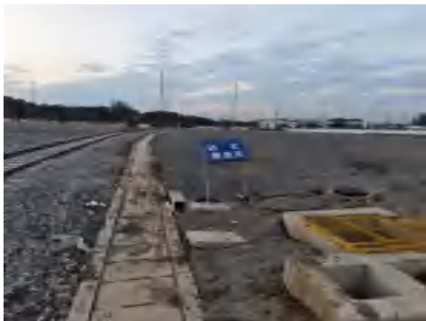
混凝土盖板排水（2025.9）
