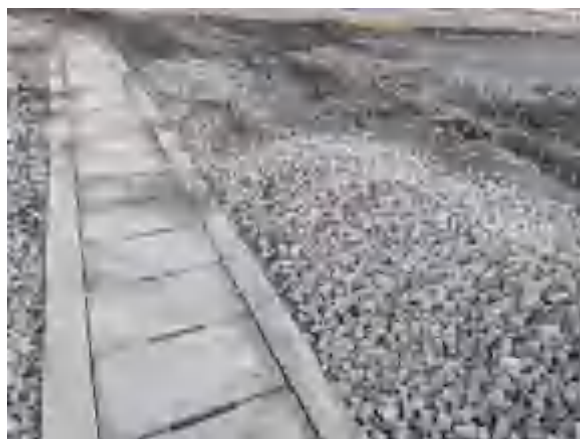
混凝土盖板排水（2025.9）
